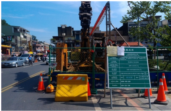
立井搖管施工作業
