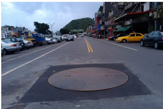
覆工板完成路面 AC 鋪修作業
