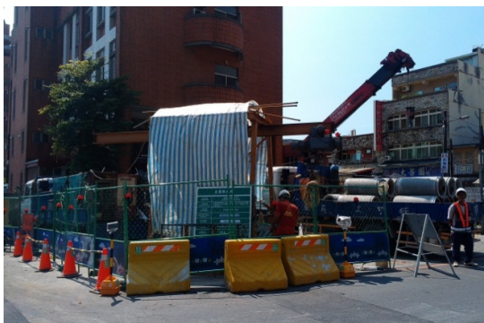
400mm 推管施工作業
