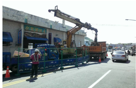
立井土方挖除清運作業
