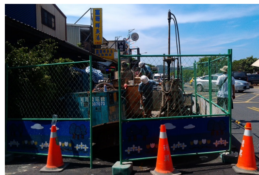
井底地質改良施工作業
