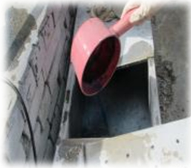
藍色示蹤劑(倒入排放口)
