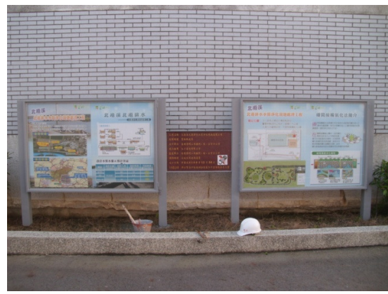
北港礫間接觸曝氣氧化廠宣導告示牌
