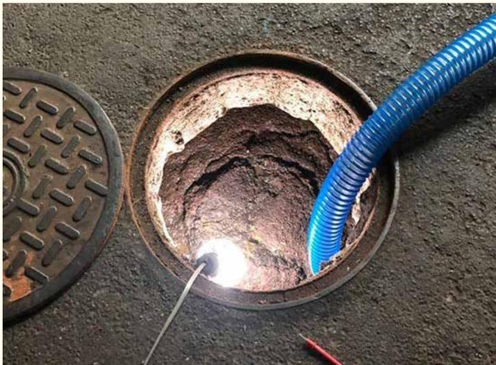
圖13 社區污水處理設施污泥清運作業
