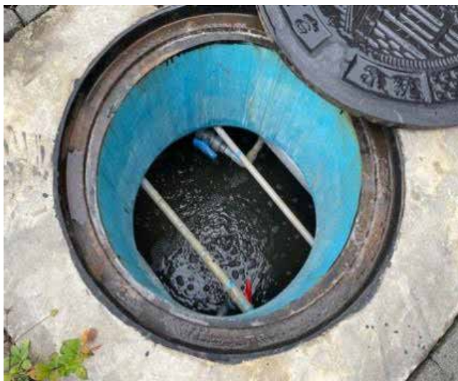
圖10 接觸曝氣槽氣泡過多
