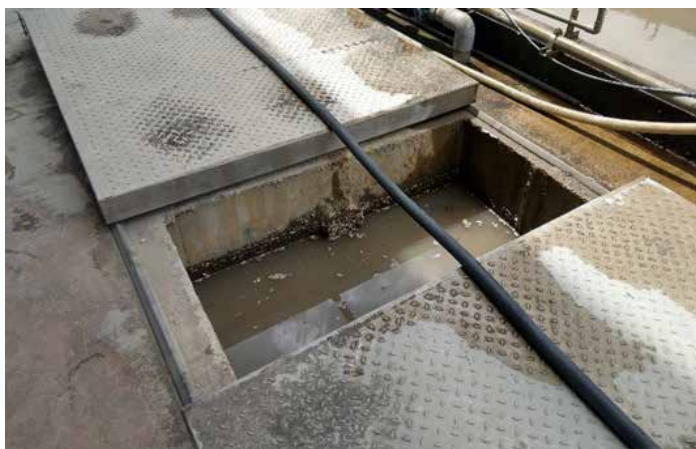
(b) RC材質場築式污水處理設施
